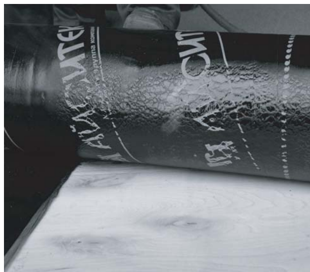
Фото 1 и 2. Пропадание рисунка на нижней стороне материала при правильном разогреве.
