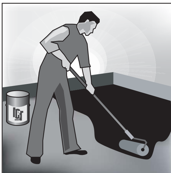
Рис. 15. Нанесение праймера.
